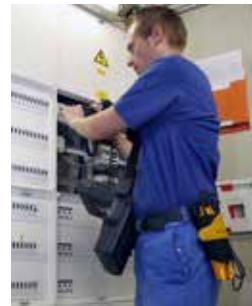
Überprüfung der Elektroinstallation
