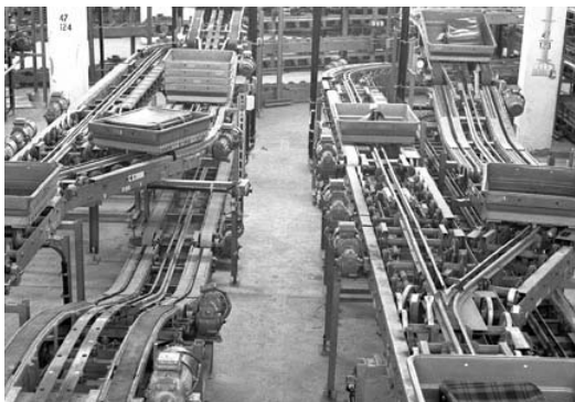
Gepäckförderanlage im Jahr 1972
