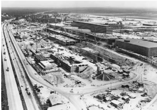
Baustelle Terminal 1, vor 1972
